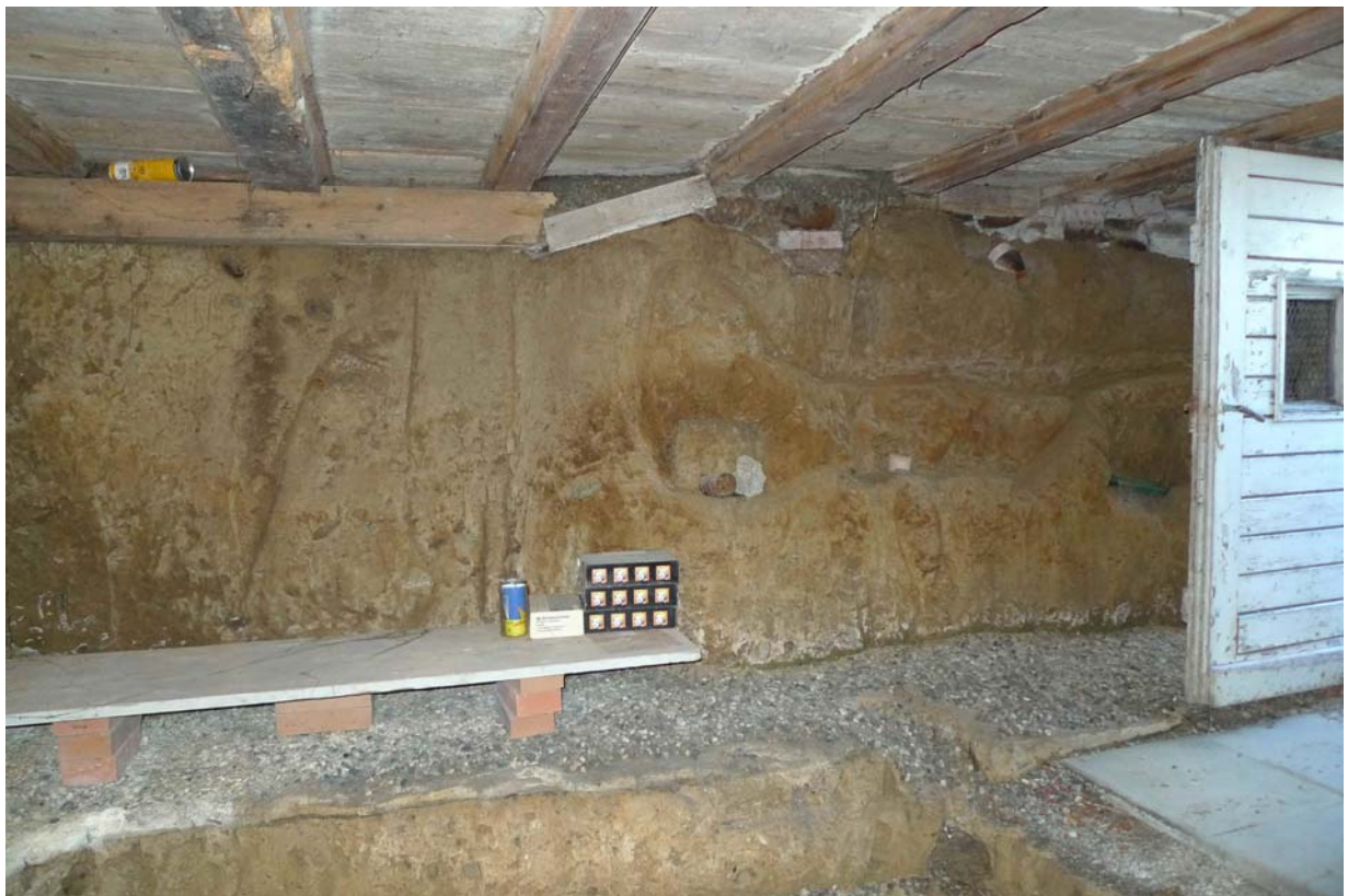
Keller im anstehenden Fels unter der südöstlichen Hinterstube (2012)
