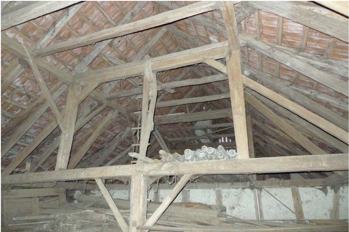
Dachtragwerk, Blickrichtung Wohnteil (2012)
