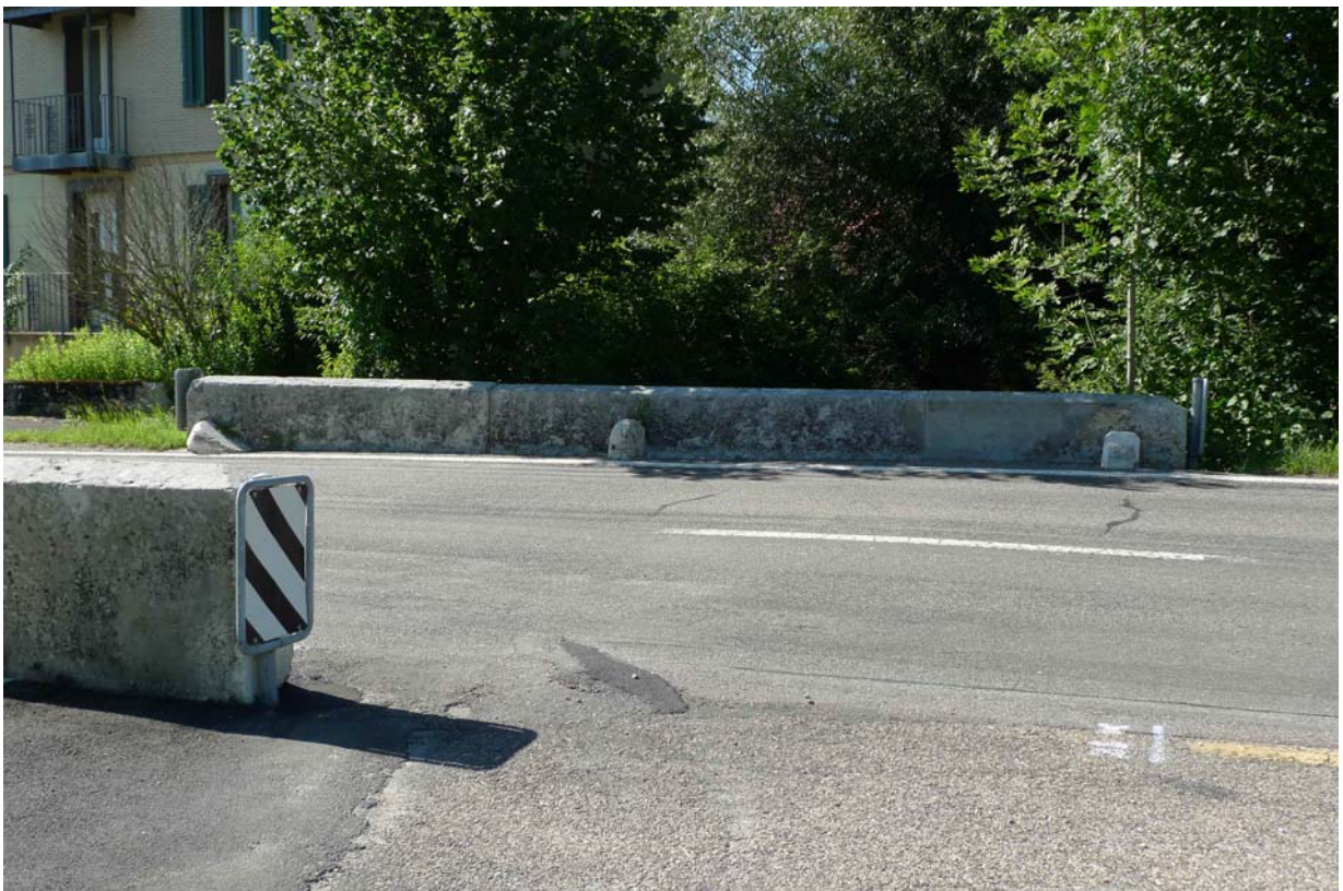
Ansicht Fahrbahn und Brüstungsmauern (2012)
