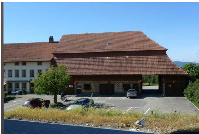
Ansicht von der Strasse (2012)
