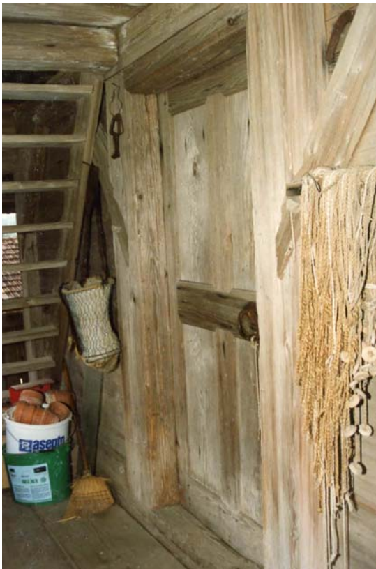
Obergadenlaube, Tür zum Speicher (1992)
