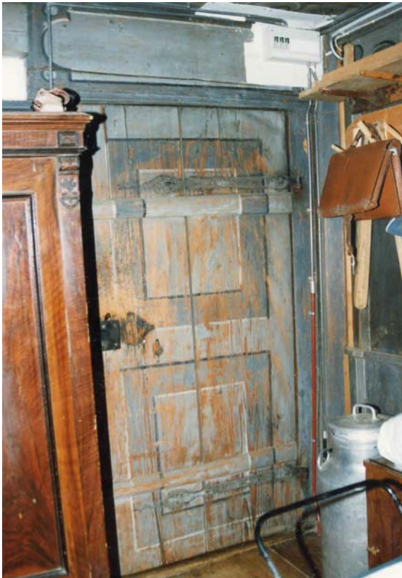
Obergeschoss, illusionistische Bemalung der Brettertür (Kurzinventar 1992)
