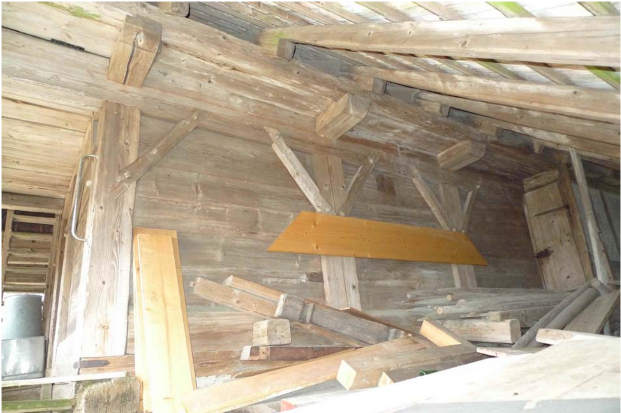
Obergadenlaube, Kopfhölzer der Bohlenständerwand (2012)
