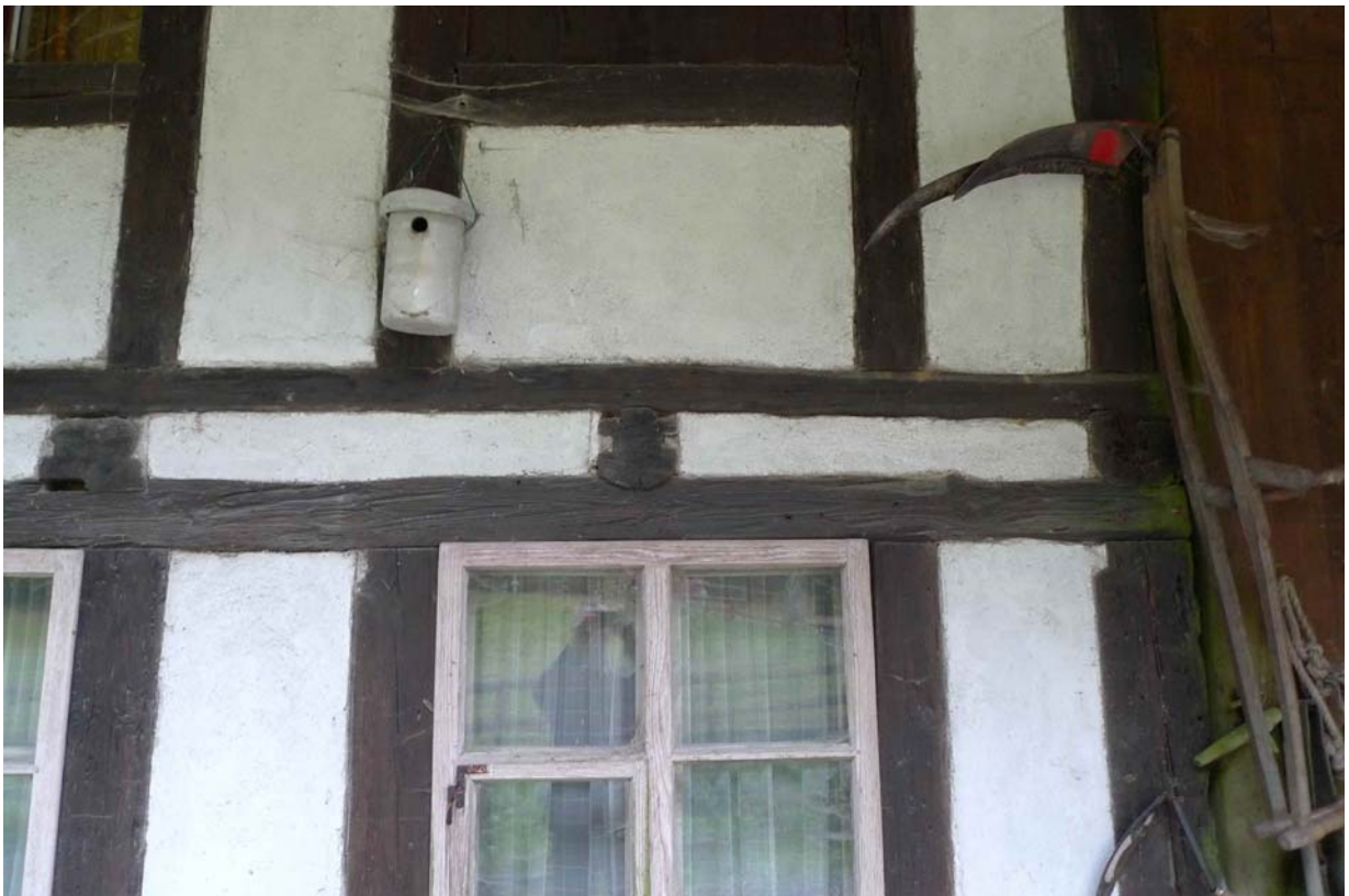
Fachwerkkonstruktion, Balkenlage über dem Erdgeschoss (2012)
