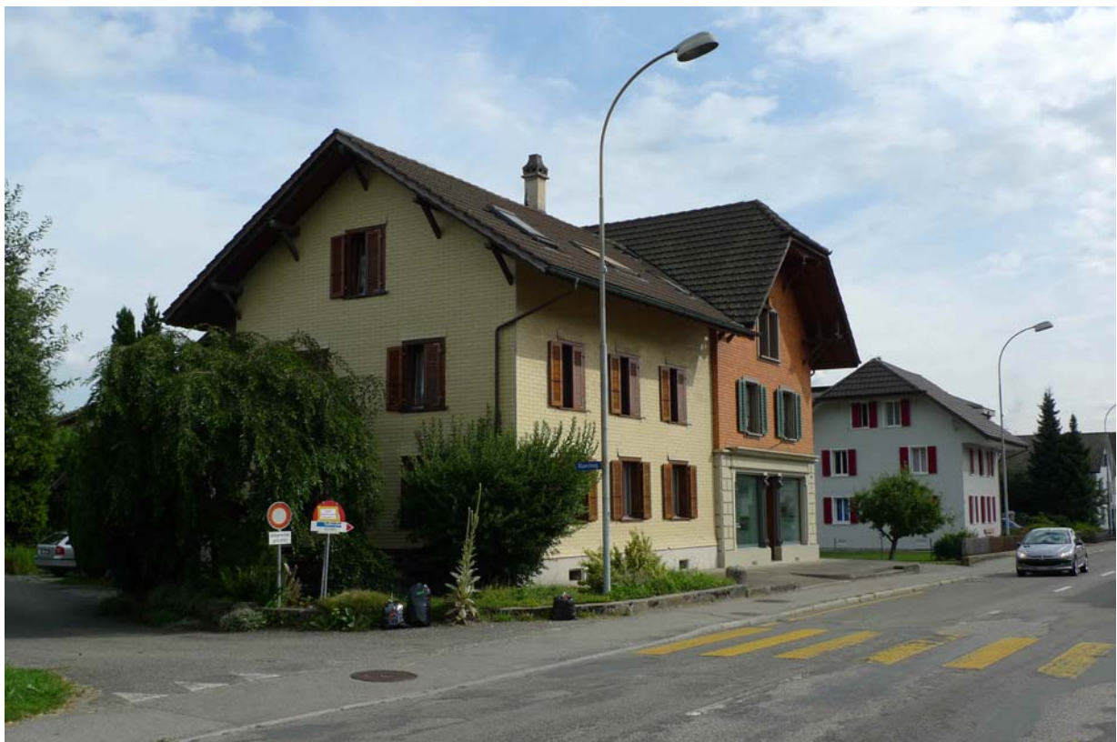
Gesamtansicht von Süden (2012)
