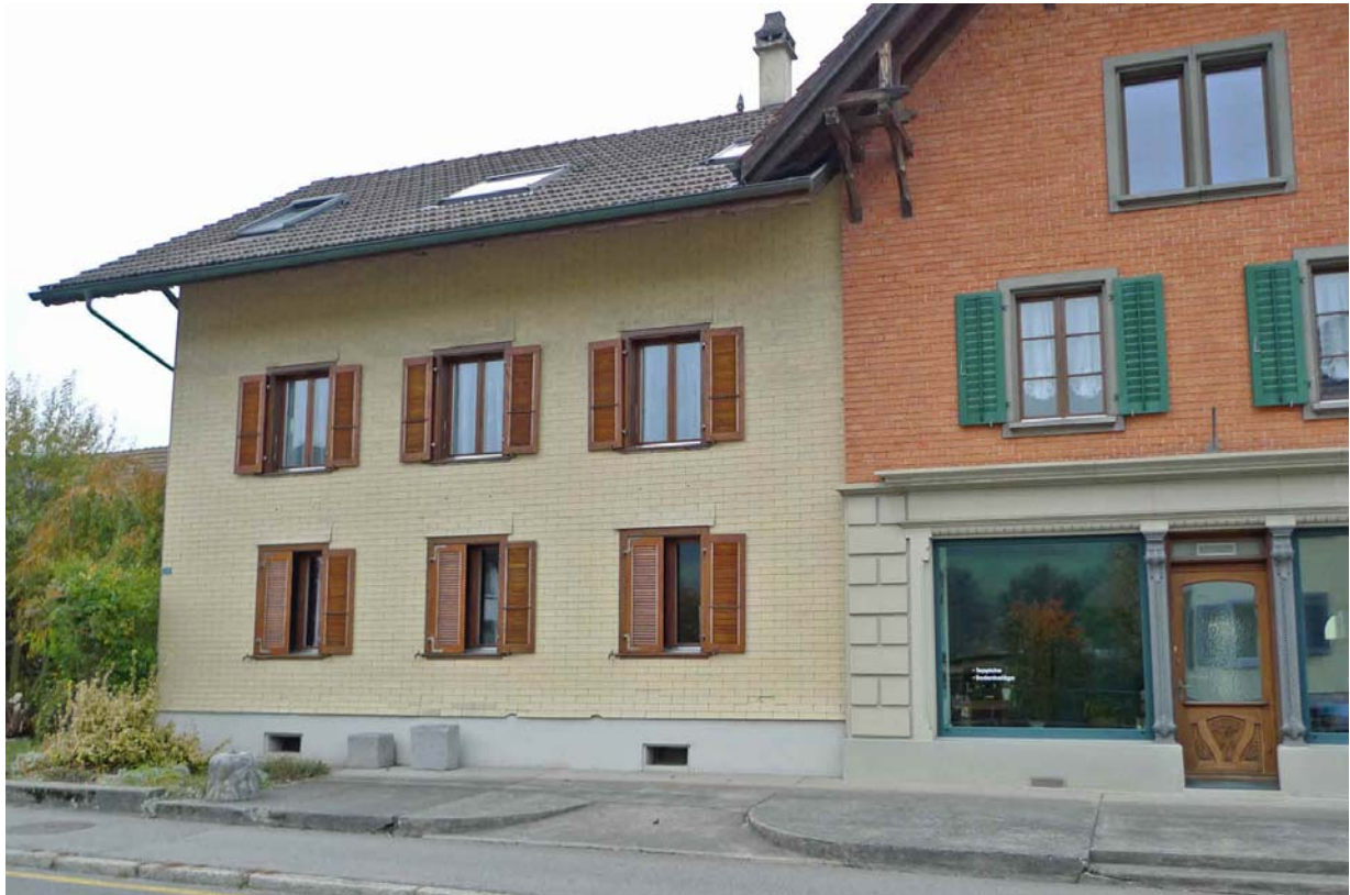
Traufständiger Ursprungsbau, alte Post (2012)
