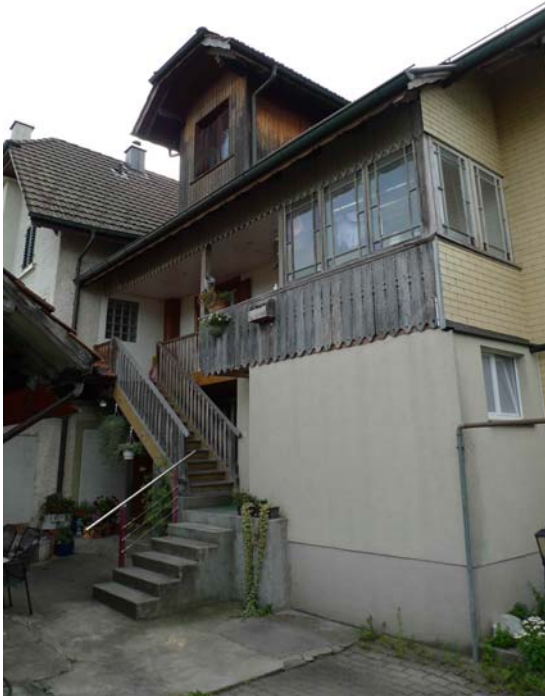
Rückwärtige Treppenerschliessung und Laube (2012)
