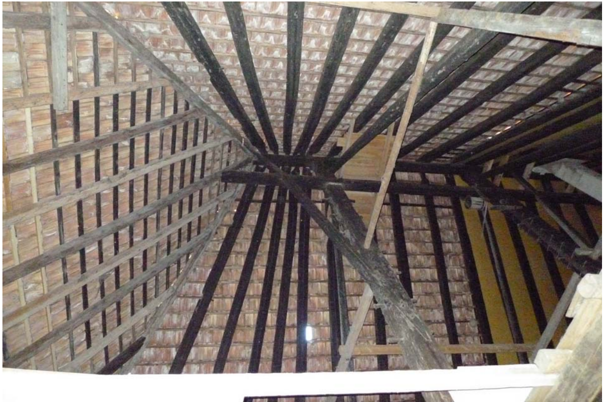
Rafenlage Hochstud über Wirtschaftsteil (2012)
