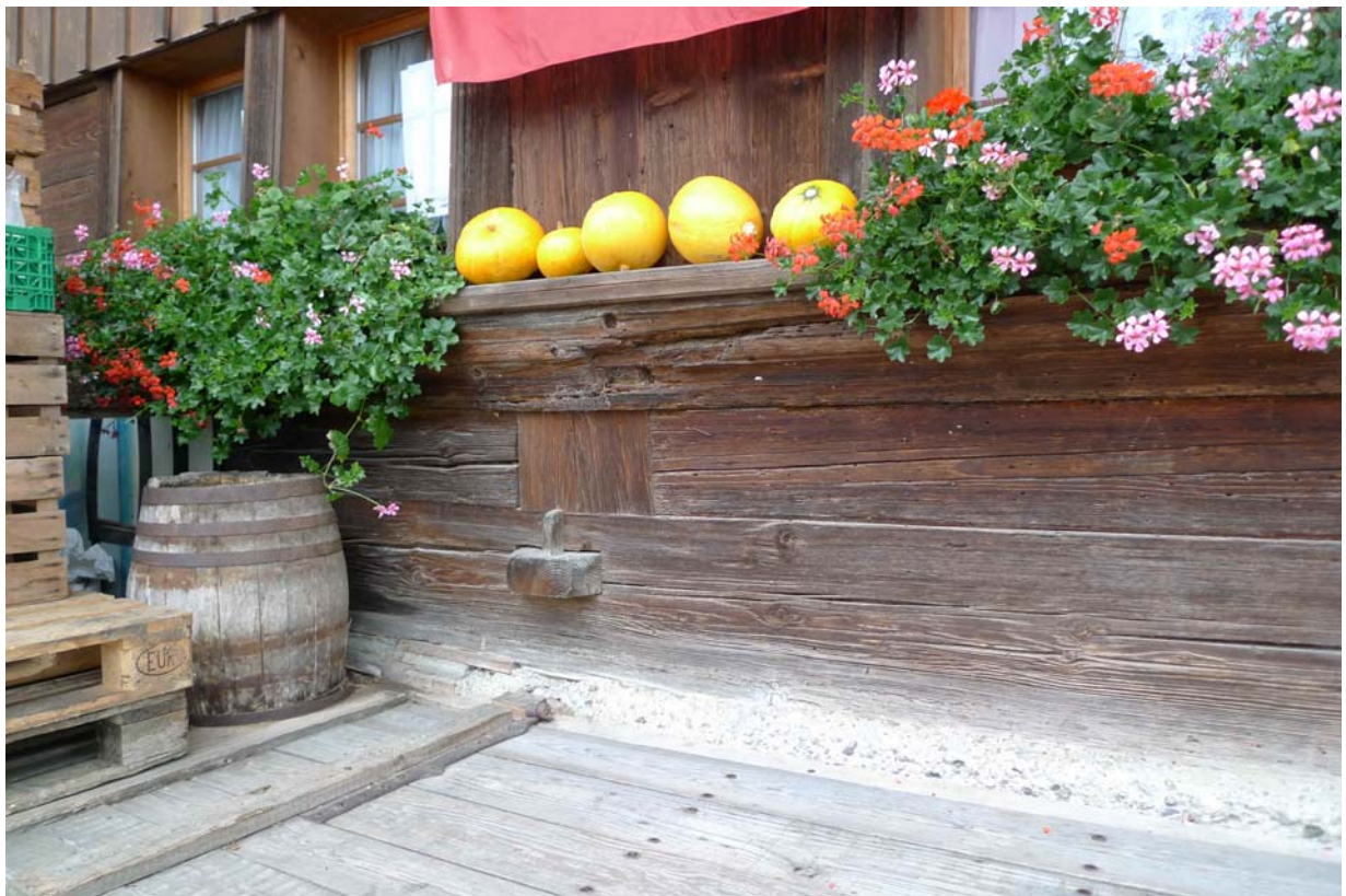
Ostfassade, profilierter Fensterbank (2012)
