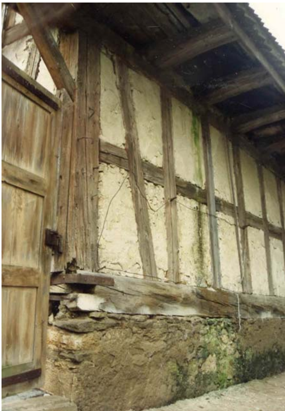
Ostseite, Fachwerkkonstruktion (1992)
