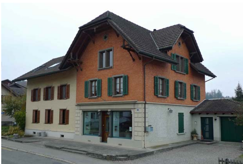
Übereckansicht von der Strasse (2012)
