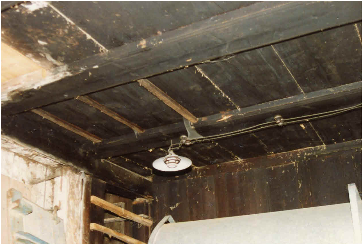
Obergaden, Sichtbalkendecke der Küche (1992)
