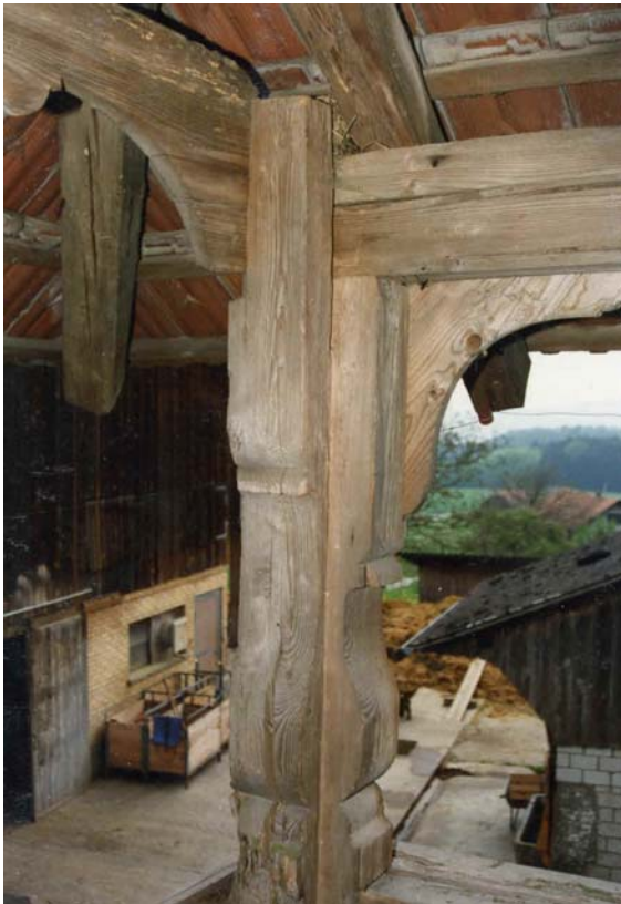
Obergadenlaube, beschnitzte Laubenpfosten (1992)
