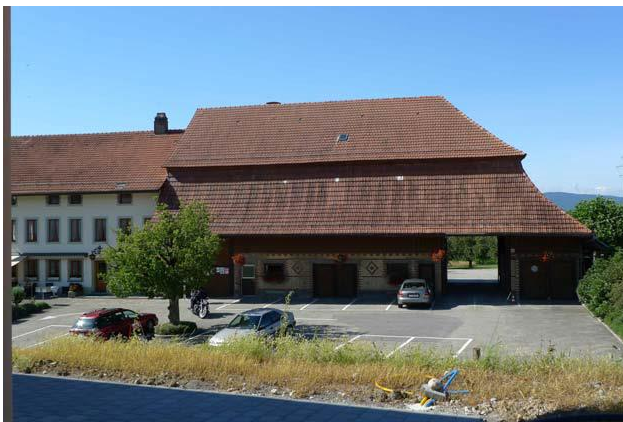
Abbildung 6: Ansicht der Stallscheune von Süden 8
