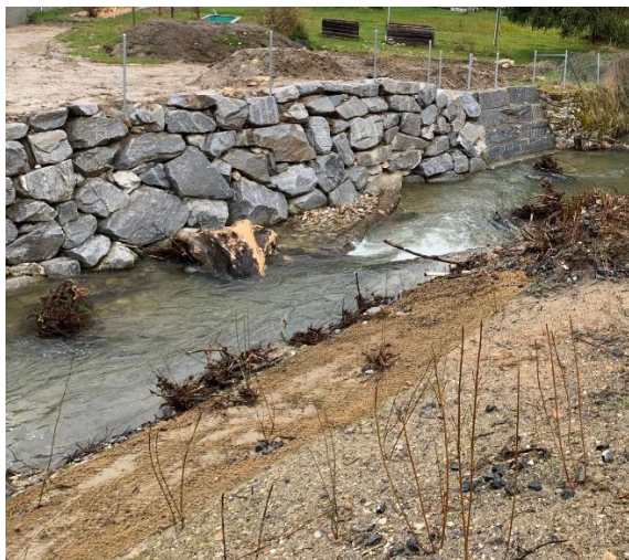
Abb.12: verbesserter Hochwasserschutz der Pfaffnern und naturnah gestaltete Ufer mit Holzelementen und Kleinstrukturen x
