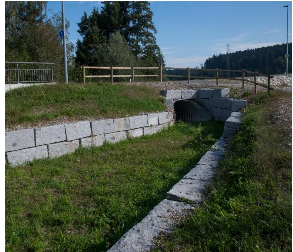
Abb.11: Hochwasser-/Kleintierdurchlass (Nähe Kreisel beim Restaurant "Zur unteren Säge")*
