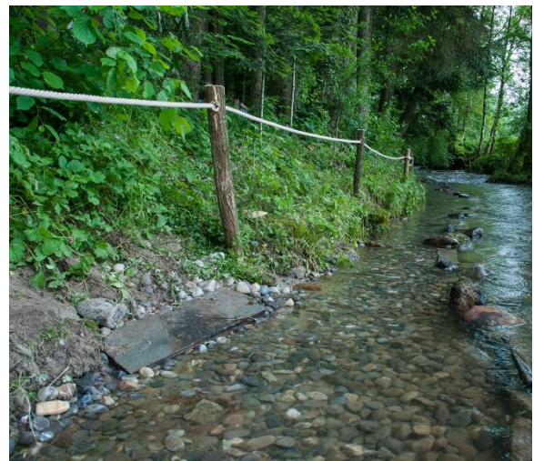
Abb.13: Kneippanlage an der Pfaffnern beim Nautrerlebnispfad (Start des Pfads beim Gemeindezentrum)*
